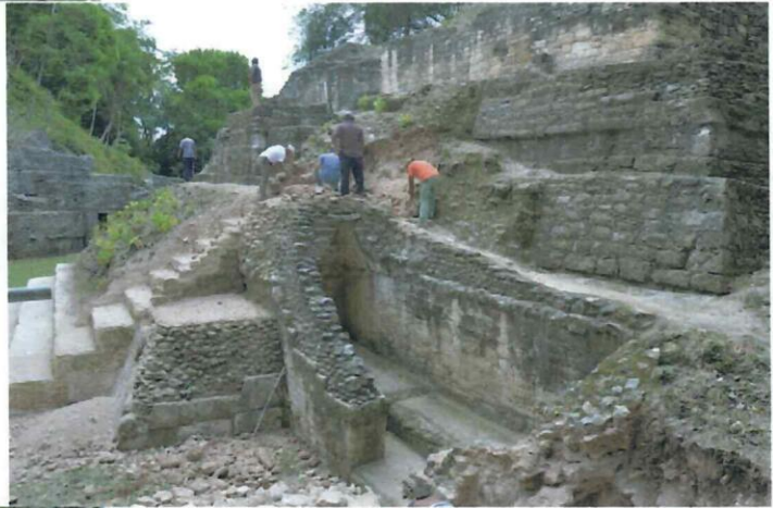
Trabajos de liberación de embudo y ampliación de acceso para visitantes en el acceso de la estructura B.14. Fotografía Livni Almira, 2021.
