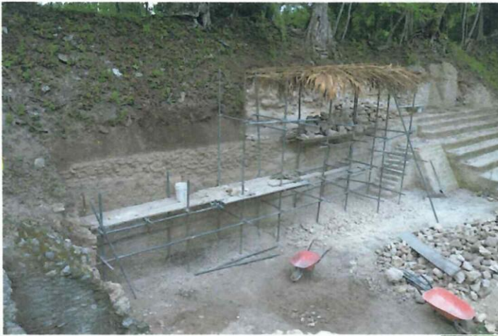
Restauración de fachada oeste edificio B-17. Fotografía Livni Almira, 2021.
